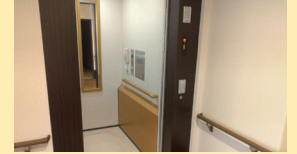
● エレベーター
