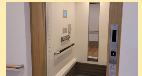
● エレベーター
